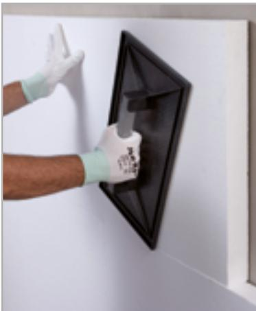
Fig. 6.8 - Presionado del panel con un fratás
