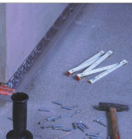
Fig. 6.3 - Posicionamiento del perfil de arranque: asegurar la perfecta horizontalidad mediante un nivel de burbuja
