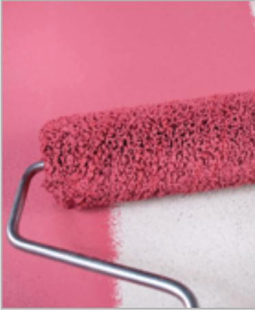
Fig. 6.14 – Aplicación de imprimador pigmentado
