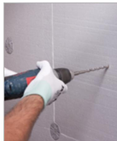
Fig. 6.9 - Realización del taladro para insertar el taco
