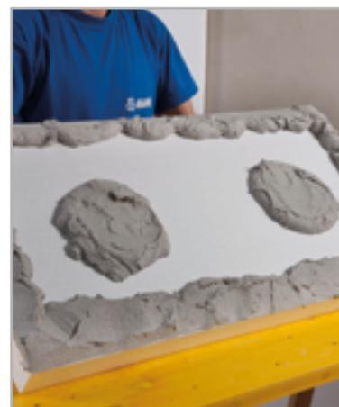
Fig. 6.6 - Distribución del adhesivo a cordón perimetral y puntos centrales sobre el reverso del panel aislante
