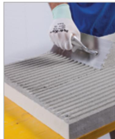
Fig. 6.5 - Distribución homogénea del adhesivo sobre el reverso del panel aislante
