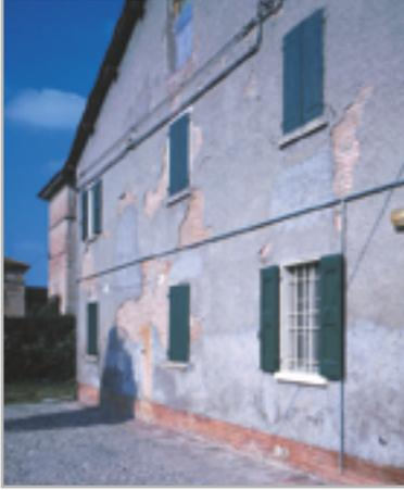
Fig. 6.2 – Las partes de revoque en fase de desprendimiento deben ser eliminadas antes del encolado de los paneles aislantes
