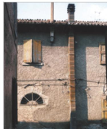
Fig. 6.1 – Edificio de albañilería afectado por humedad de remonte capilar
