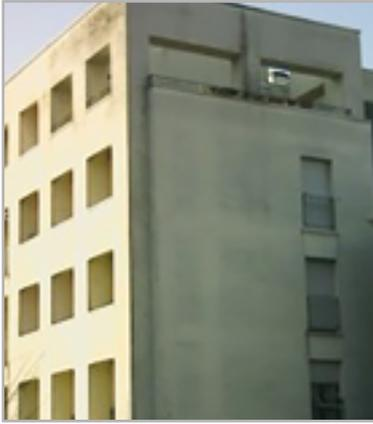
Edificio exento de aislamiento térmico por el exterior en el que se evidencian los puentes térmicos de la estructura (vigas y pilares). Los cerramientos del muro presentan agresiones biológicas dado que están más fríos
