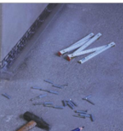
Fig. 6.4 - Fijación del perfil de arranque mediante tacos de expansión
