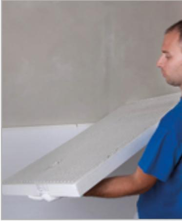
Fig. 6.7 – Colocación del panel aislante a rompejuntas
