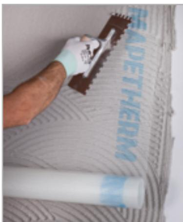
Fig. 6.12 – Puesta en obra de MAPETHERM NET
